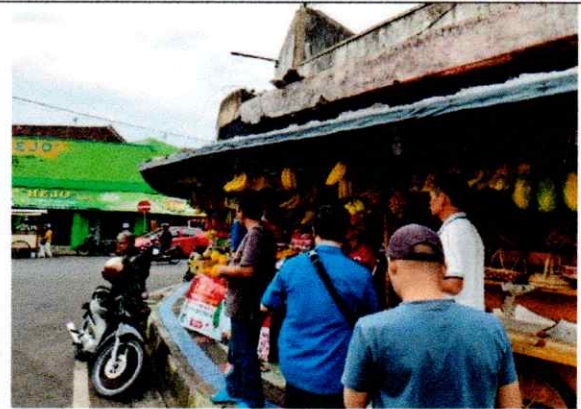
Lokasi pemasangan pipa JDU diameter 250 mm metode boring manual di Jl. RE. Martadinata
